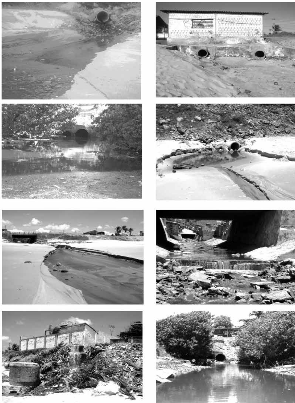
Figura 3 - Galerias pluviais usadas para o escoamento de esgotos no litoral oeste de Fortaleza.
