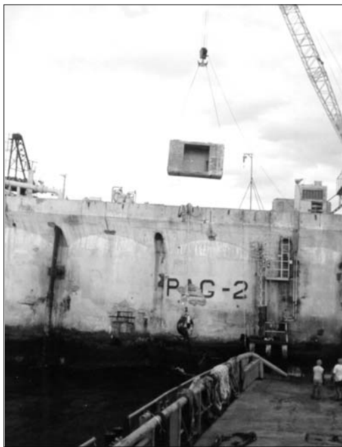
Figura 2 - Casulos de concreto sendo retirados da Plataforma Agulha 2 para bordo do rebocador, para a triagem.
