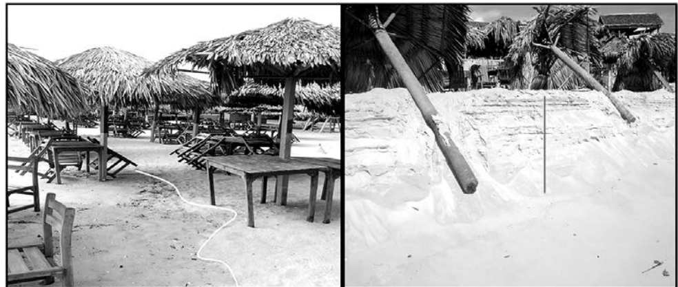
Figura 8 - À esquerda, ocupação de barracas-de-praia e estruturas na faixa de praia e pós-praia; à direita, linhas de preamar e escarpas indicam a atuação e o alcance das ondas na Prainha de Aquiraz (fonte: autor, em 2012).
