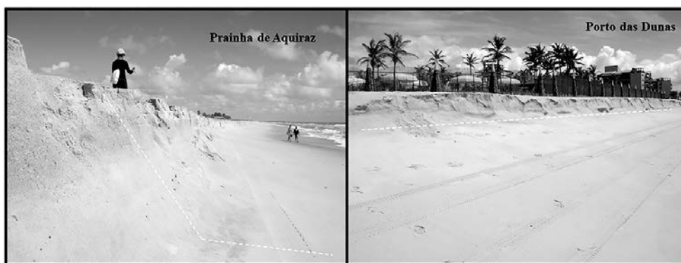
Figura 7 - À esquerda, na Praia de Aquiraz destaca-se o ângulo que se forma entre o estirâncio e a pós-praia (escarpa); à direita, no Porto das Dunas, formação de escarpas próximas à estrutura do Beach Park Resort ( fonte : autor, em agosto de 2011).
