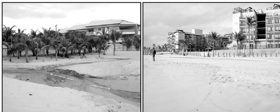
Figura 10 - A maciça ocupação da praia do Porto das Dunas e alcance das ondas próximas às estruturas durante a maré cheia (fonte: autor, em 2011-2012).
