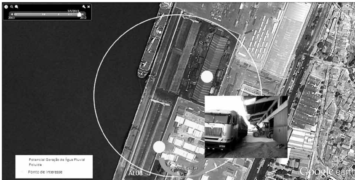
Figura 6 - Área de geração de efluentes na operação de fertilizantes e coque das empresas Galvani e Multilog. Em detalhe o tanque de sedimentação.
