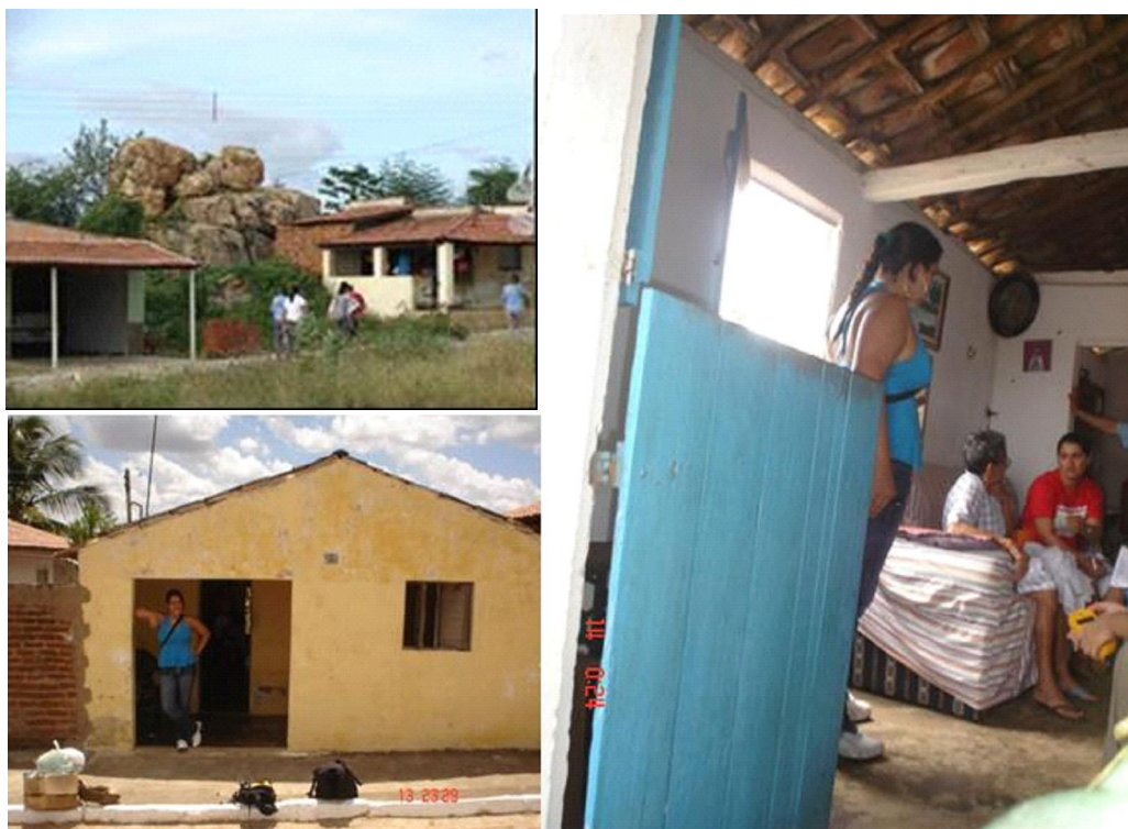
Fig. 3 - Casas típicas da região do Seridó, Lages Pintadas, Rio Grande do Norte. Salienta-se a fotografia do canto superior esquerdo onde se pode ver uma casa construída em cima de dique pegmatítico.
