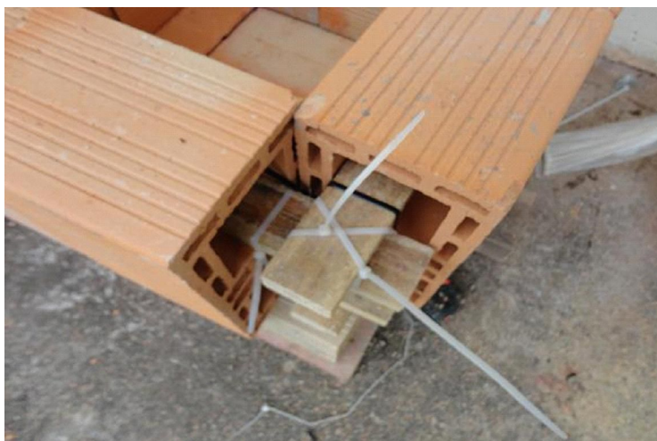
Figura 9 - Detalhe das abraçadeiras fixando o madeiramento das laterais da célula-teste de bloco estrutural.
