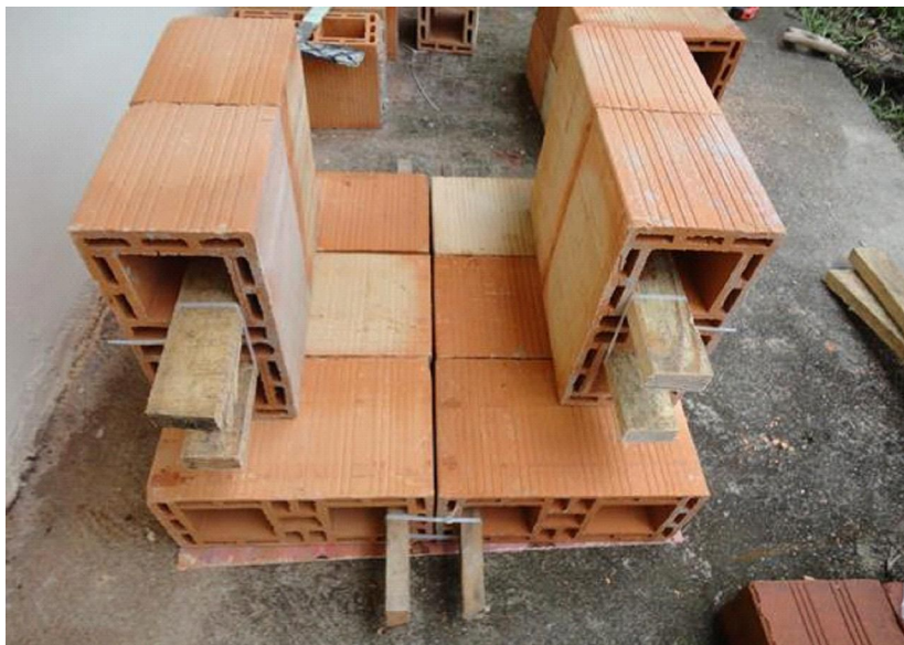
Fig. 7 – Etapa intermediária da construção da célula-teste de blocos cerâmicos estruturais
