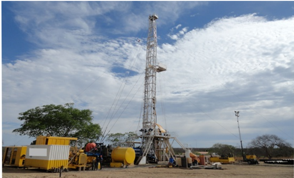
Figura 6: Perfuração de um poço tubular na região do município de São João da Canabrava-PI.
