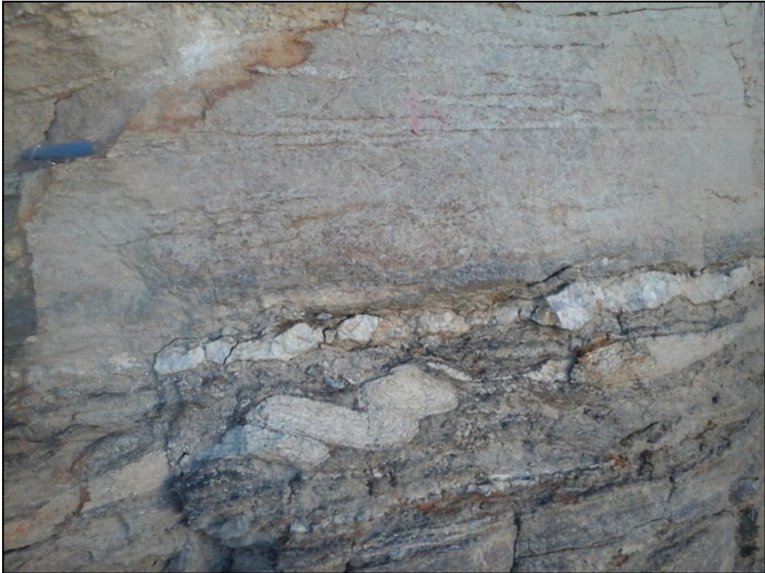
Figura 3: Estruturas tectônicas boudins em xisto, representando um dos pontos vulneráveis à erosão.
