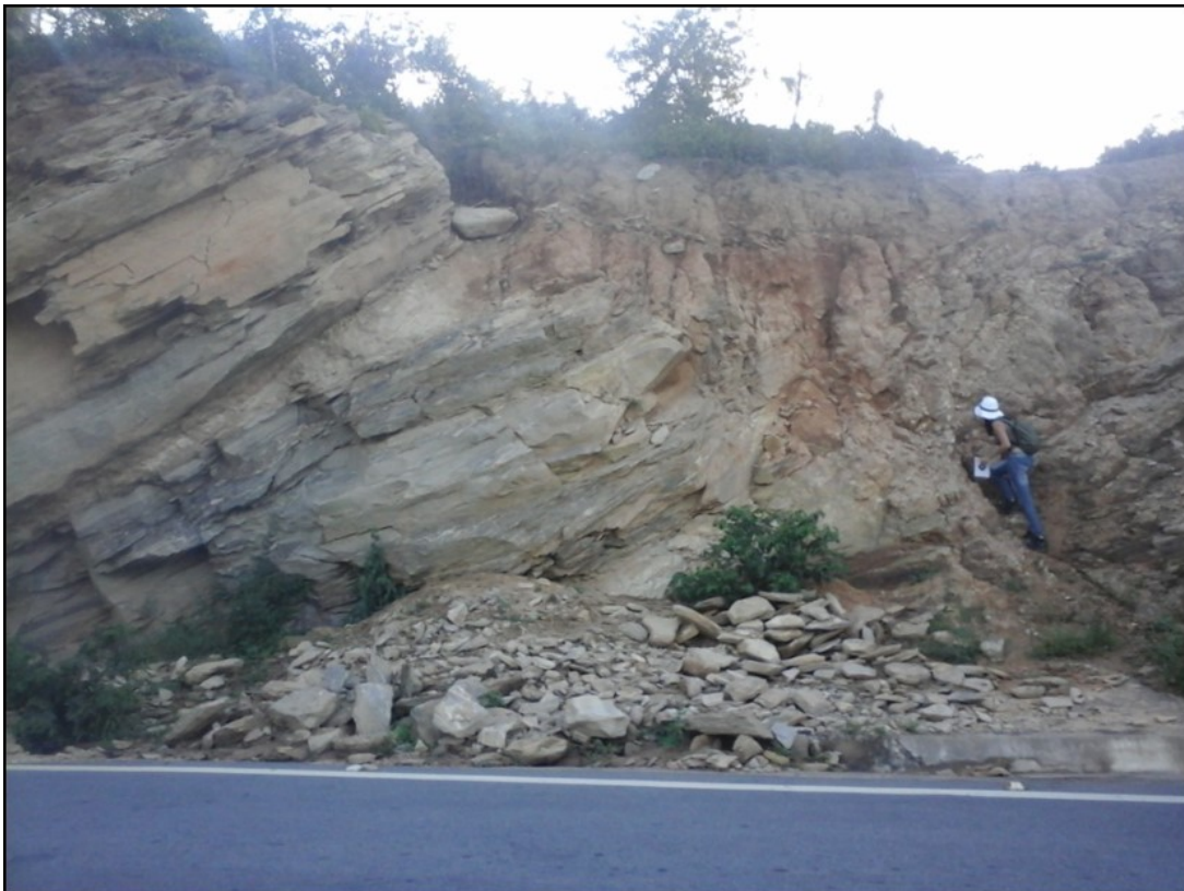
Figura 4: Rampa de ruptura planar, cujas orientações espaciais e mergulhos de planos de falhas, fraturas e foliações são condicionantes de primeira ordem associados a movimentos de massa.
