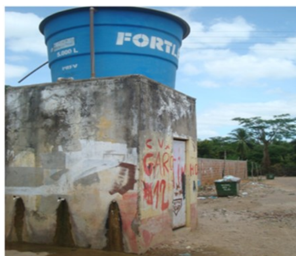
Figura 5: Observa-se a ocorrência de lixo e esgoto nas imediações do poço no bairro Mutirão Bela Vista (08/2012). Coordenadas do poço: 297888 /9583984 (UTM SAD 69).
