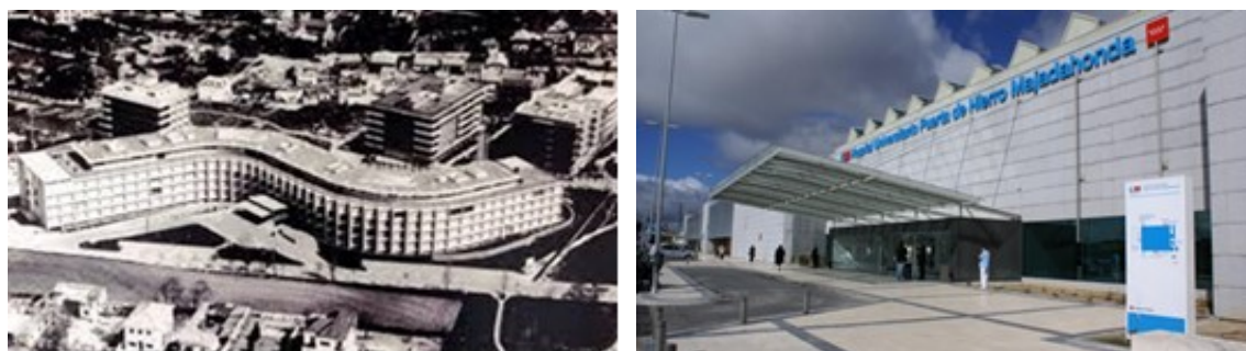
Figura 4: Sedes del Hospital Universitario Puerta de Hierro (1964 y 2008)
