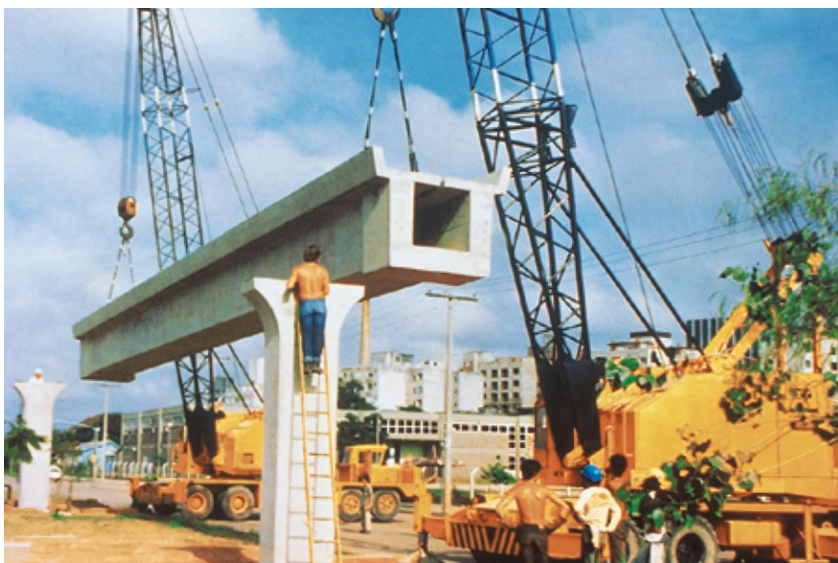
Figura 3 — Linha Piloto começa a ser construída
