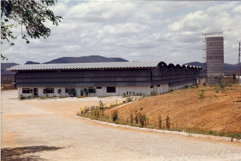
Foto 2: Fábrica Acarape (CE)
