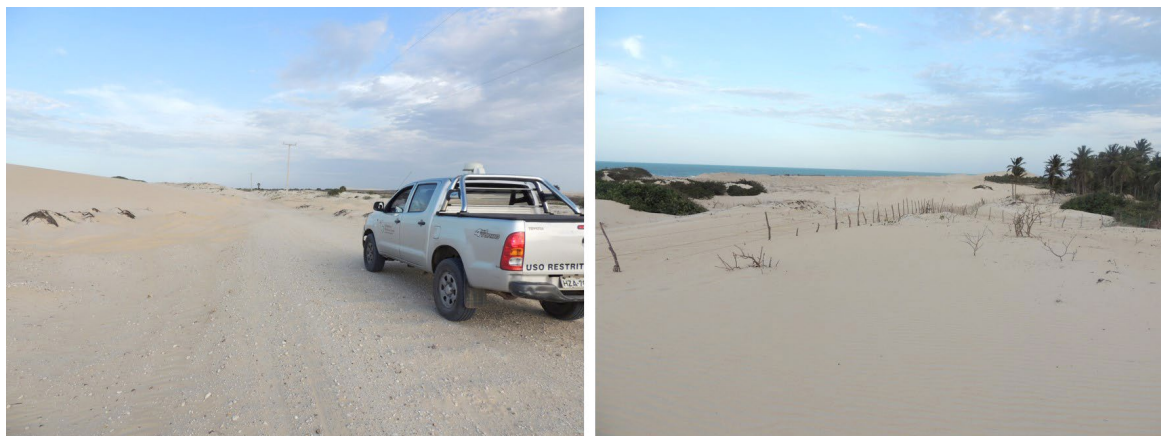
Figura 4 – Migração de dunas e soterramento de estrada de acesso à localidade de Curimã, com destaque para o loteamento de áreas com transporte eólico intenso
