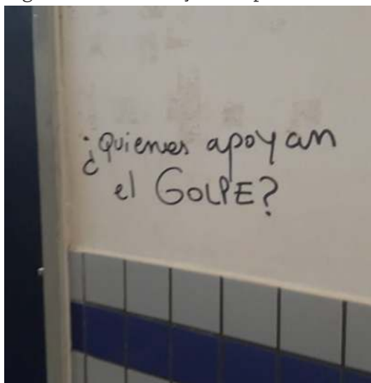
Figura 1 – Intervenção em parede interna
