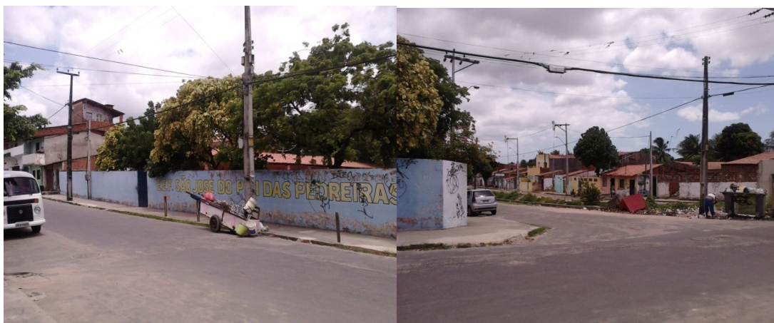
Figura 3– Fachada da Escola
