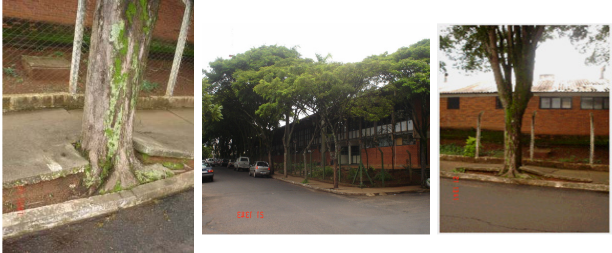
Foto 1, 2 e 3 – Raízes destroem calçadas; Conflitos entre arborização e iluminação; Fonte: CROSARA, 2010.
