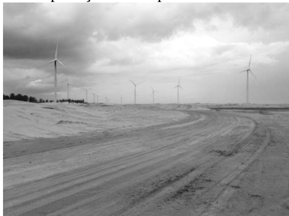
Figura 2 – Compactação do campo de dunas. Eólica Morgado
