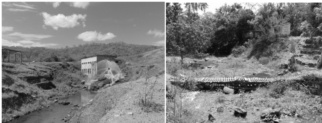
Figura 02: Válvula da regularização de vazão. Figura 03: Trecho do rio Caxitoré.
