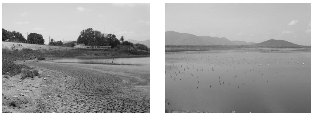
FIGURA 5 E 6: AÇUDE VÁRZEA DA VOLTA
