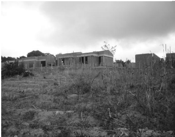
FIGURA 03: ALTO CURSO DA MICROBACIA DO RIO SALAMANCA, CONSTRUÇÃO DE RESIDÊNCIAS.
