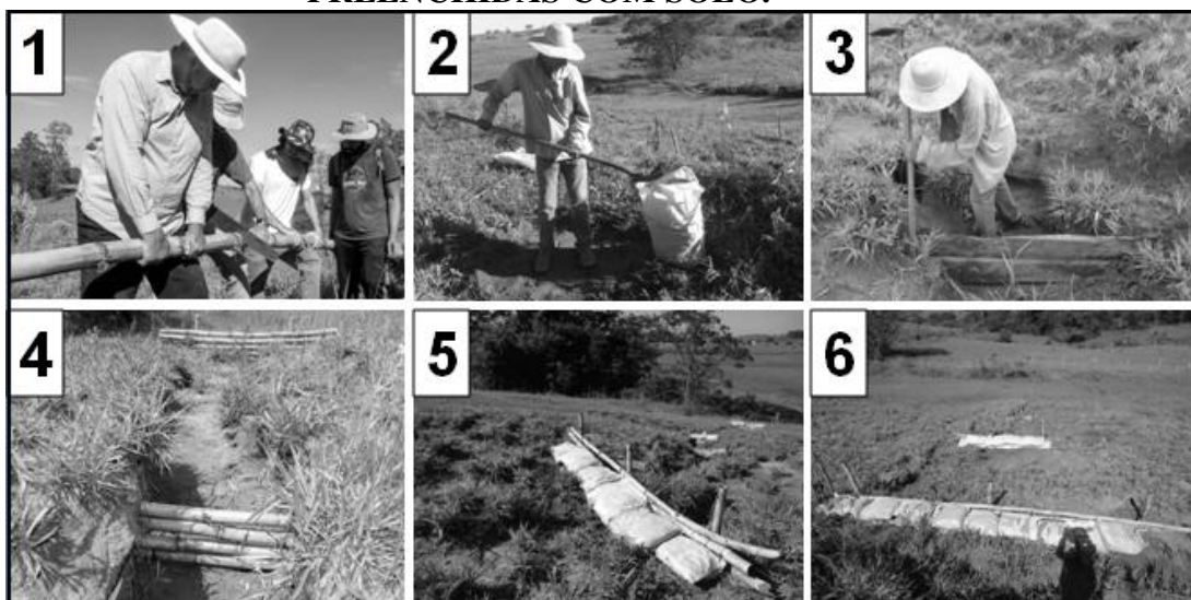
FIGURA 1: MONTAGEM DAS PALIÇADAS E DAS SACARIAS DE RÁFIA PREENCHIDAS COM SOLO.
