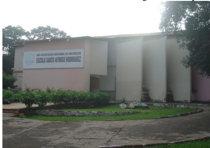
Figura 1. Fachada da Escola Santo Afonso Rodriguez, município de Teresina/PI
