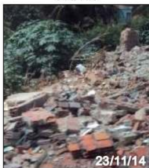
Figura 12 – Residência que desabou devido às chuvas
