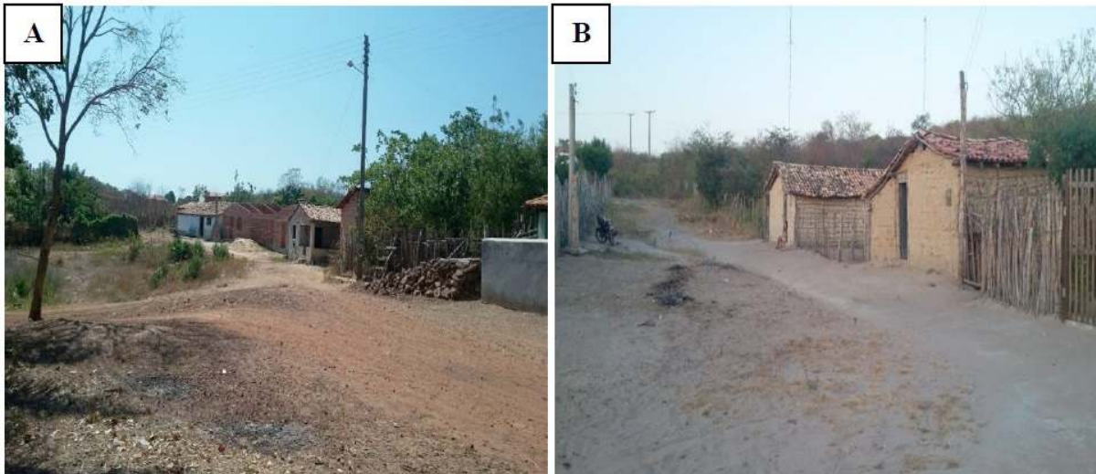
A: Casas construídas em locais inadequados de moradia, nos arredores da Lagoa Grande, sujeito a alagamento em períodos de cheia. B: Casas construídas em locais inadequados de moradia e sem infraestrutura necessária. Fonte: Pesquisa Direta (2019)
