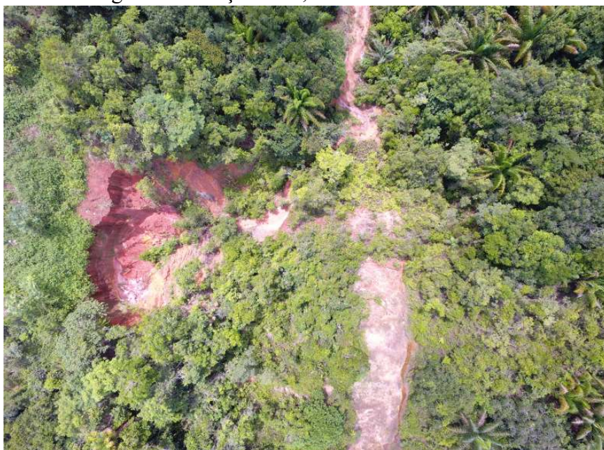
Figura 12 - Voçoroca 3, na cidade de Rio Preto
