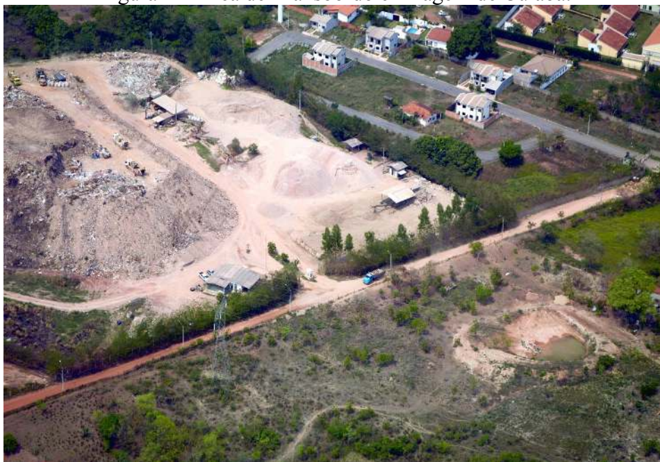
Figura 1 – Área de Transbordo e Triagem de Cuiabá.
