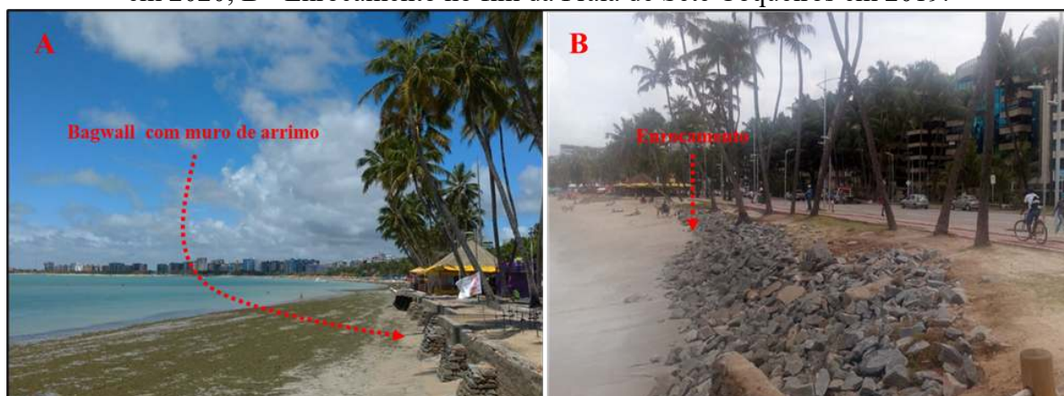
Figura 9 – Localidades com estruturas de contenção. A: Bagwall na Praia de Sete Coqueiro em 2020; B - Enrocamento no fim da Praia de Sete Coqueiros em 2019.
