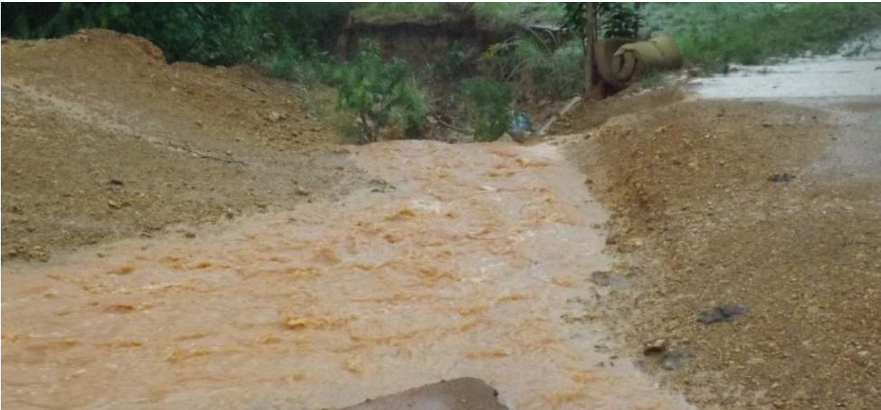
Figura 10 - Feição erosiva (voçoroca) observada no período de implantação do loteamento Jardim Nova América (Fotografia: Lucas B. Souza, março/2015).
