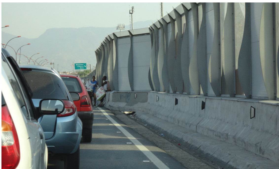
Figura 3 - Muro (“barreira acústica”) da Linha Vermelha junto ao Complexo da Maré Foto: Rogério Haesbaert, 2012.
