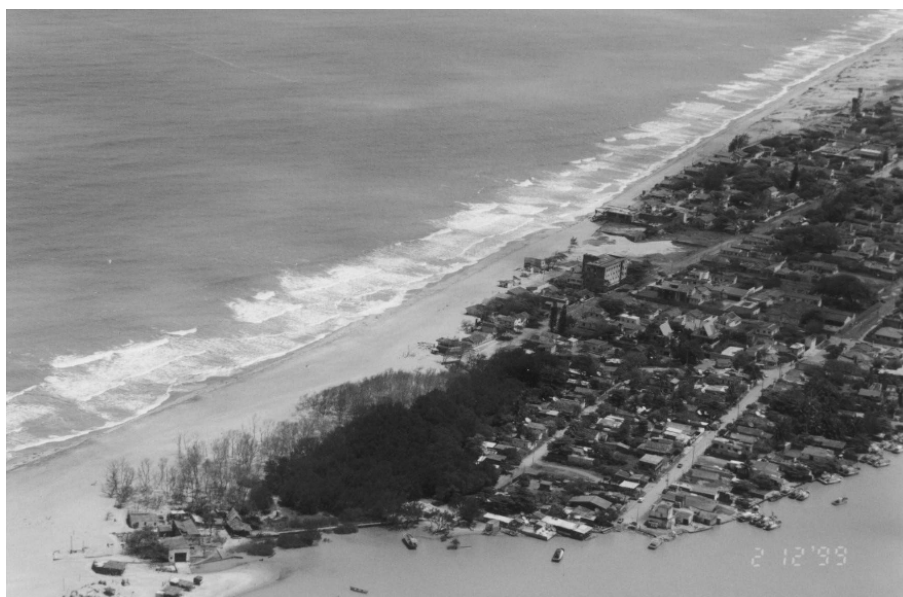
Figura 8 - Erosão da frente oceânica na margem direita da desembocadura do Paraíba do Sul em Atafona.
