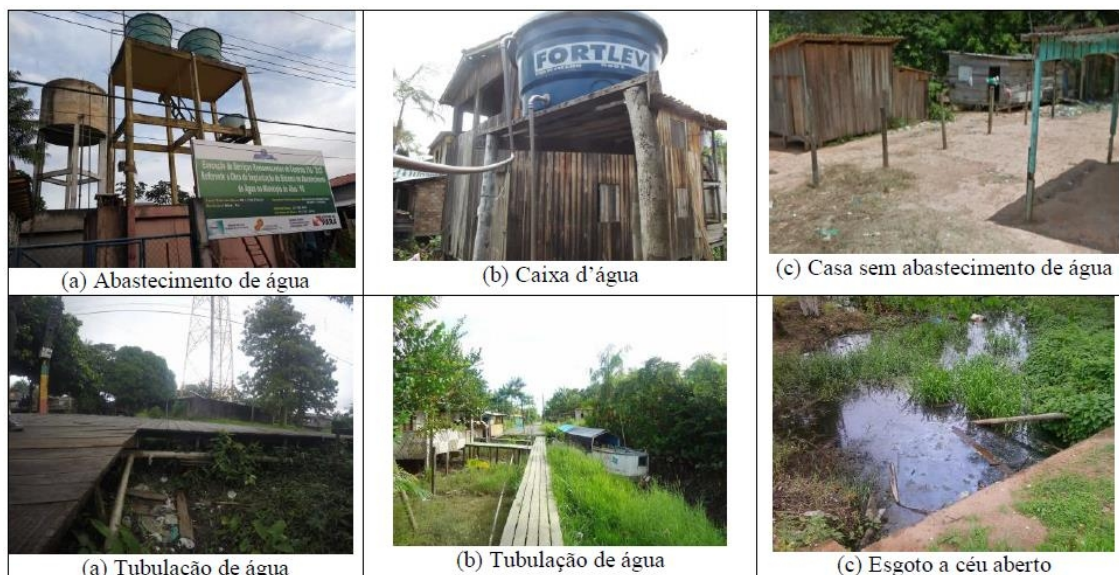
Figura 5 - Exemplos da realidade do sistema abastecimento de água e de coleta de esgoto nas cidades de Afuá (a), Ponta de Pedras (b) e Mazagão.
