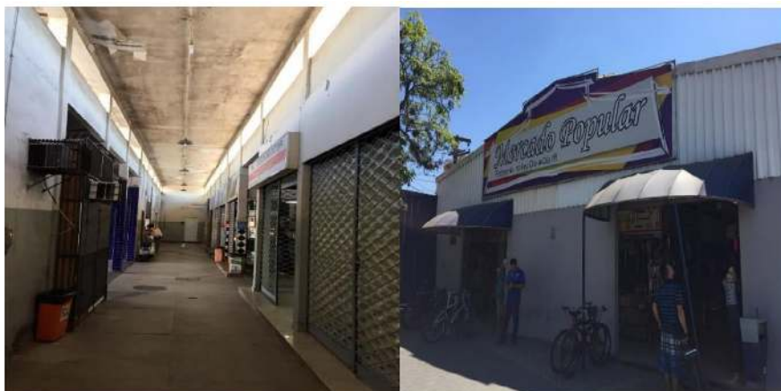
Figura 5 - Parte interna do Antigo Terminal Rodoviário de Resende – 2018. Figura 6 - Mercado Popular – 2018
