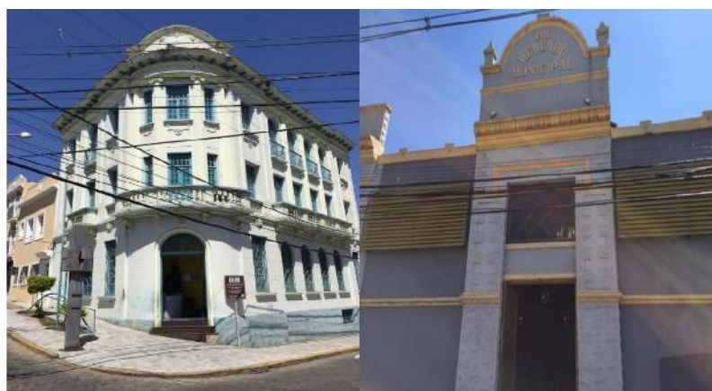
Figura 7 - Câmara Municipal de Resende, 2018. Figura 8 - Mercado Municipal de Resende, fachada – 2018
