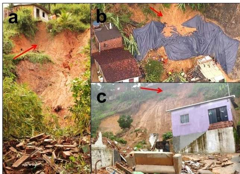
Figura 4 - Exemplos de escorregamentos ocorridos na Região Metropolitana do Recife (RMR): (A) Escorregamento ES0223 no município de Camaragibe, (B) Escorregamento ES0369 também no município de Camaragibe e (C) Escorregamento ES3125 na zona norte do município de Recife, dos quais, em todos observa-se a ocorrência dos processos em áreas precariamente instaladas com muitas perdas sociais e econômicas. Fontes: (A) Diário de Pernambuco (2015), (B) Portal G1 PE (2019) e (C) Diário de Pernambuco (2015).
